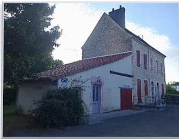
Réfection partielle de la toiture Maison des Associations Juillet 2023
